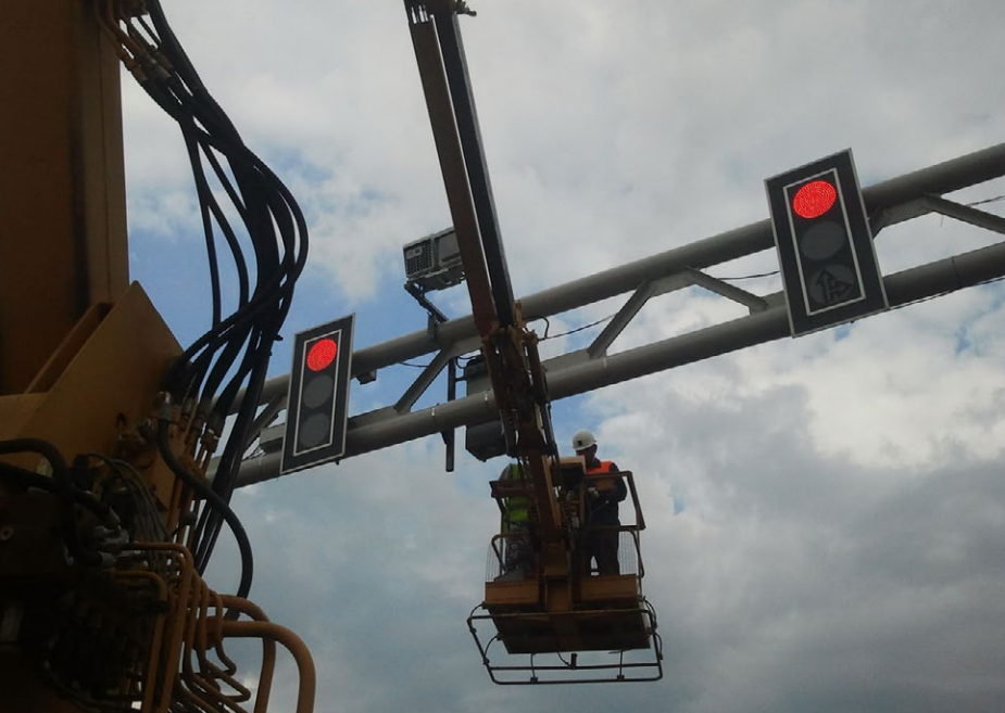
Идет монтаж оборудования.
