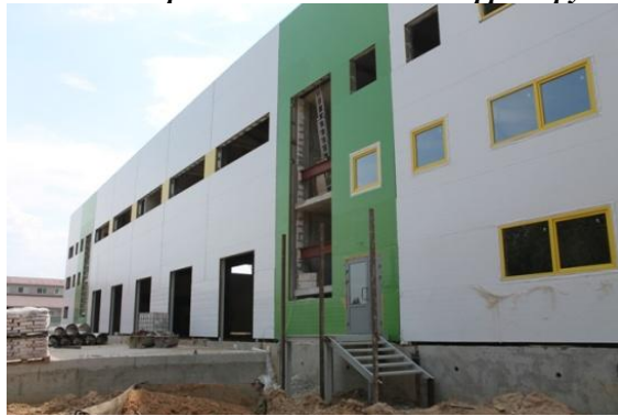
Рис. 33. Строительство складского комплекса в д. Озерцо
