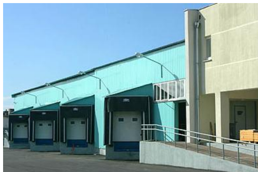
Рис. 29. Складской терминал СООО «Даймондфрут»
